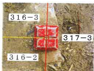
83: 既設コンクリート杭
